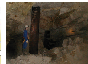
Pieux de fondation (Valenciennes) © INERIS
