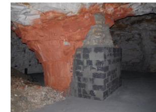
Confortement d'un pilier par maçonnerie (Lille) © INERIS
