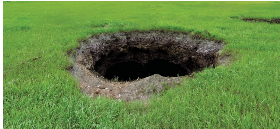
Effondrement dans une prairie © / istock
