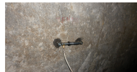
Mise en place d'un extensomètre (mesurant la déformation d'un élément de structure) à Hellemmes © Service Commun des Carrières Souterraines - Ville de Lille
