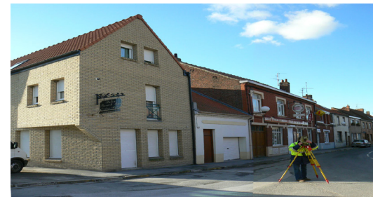
Commerce en RDC et appartement au 1er étage
