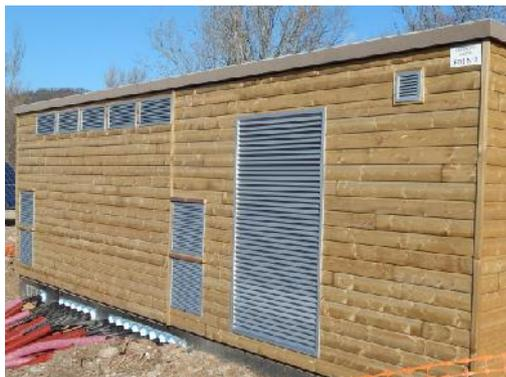
*Photo 32 : Exemple d'habillage d'un poste de transformation (source : Epure Paysage)*
