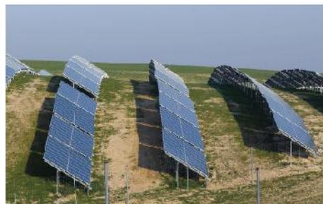
*Exemple d'implantation de petits modules sur des terrains en pentes transversales, permettant de suivre le relief et éviter des cassures visuelles.*
