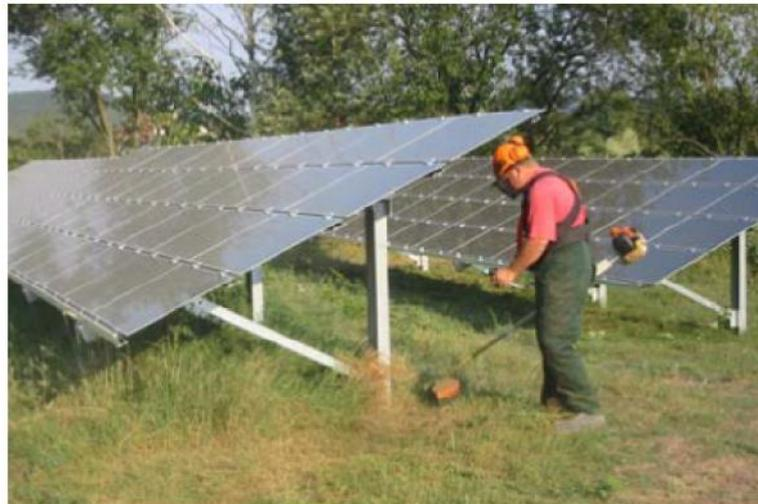
*Photo 47 : Entretien mécanique (source : Quadran)*
