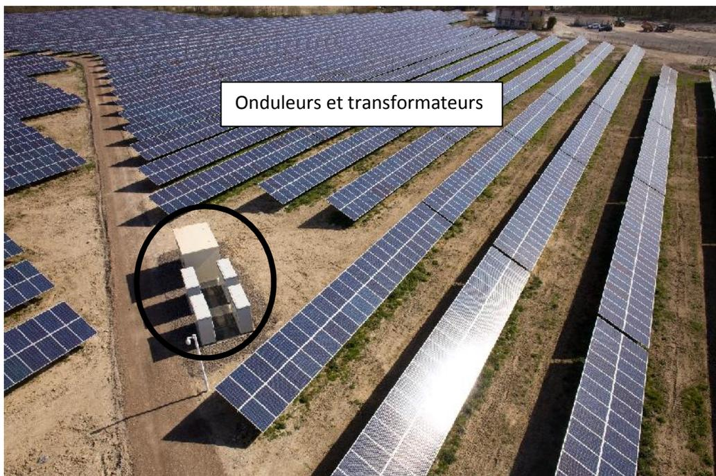
Photo 38 : Vue des onduleurs et du poste de transformation (source : centrale solaire de Batheniville, Quadran)
