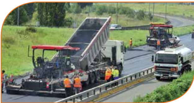
Travaux sur l'A1 en 2011 © DDTM
