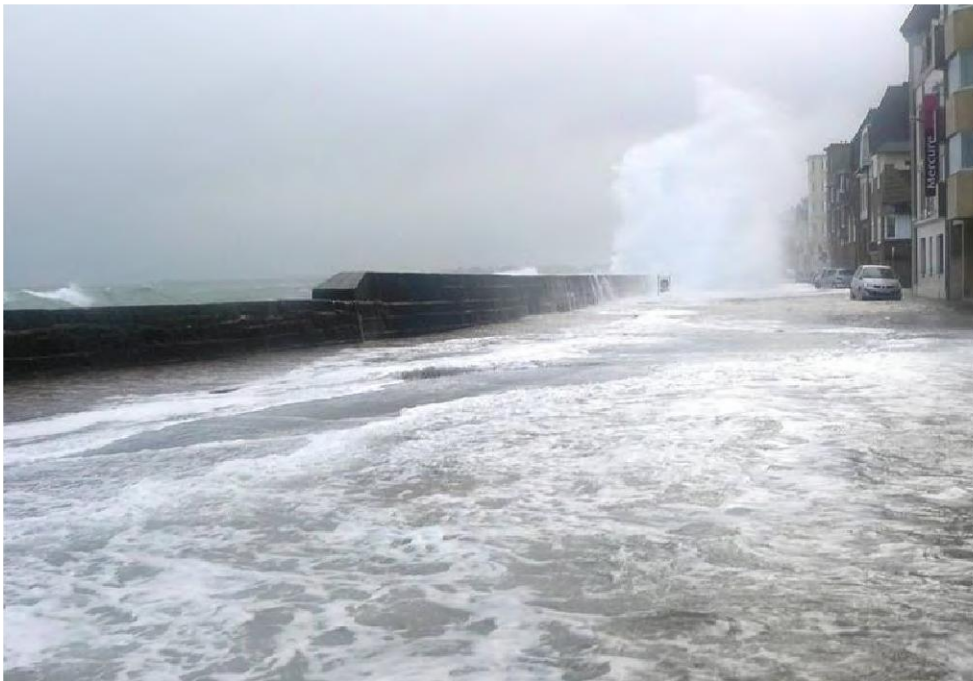
Submersion par franchissement à St Malo (source DREAL Pays de Loire)
